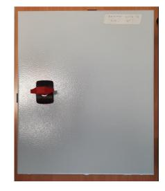
Ce coffret sera protégé par la mise en place d'un disjoncteur installé en tête de tableau divisionnaire (TD Bâtiment) par un disjoncteur 10A Courbe C avec lcc<20kA Type Schneider iC60N 2P 10A.
