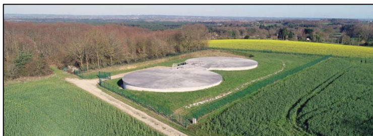
Figure 18 : réservoirs à Parigné le Polin, 2x2000 m 3 (photo issue du site du SIDERM)
