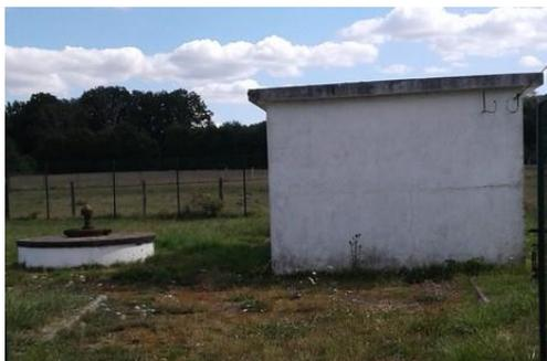
Le forage a été réalisé à une profondeur de 40 m dans l'aquifère du Turonien et est équipé de deux pompes exhaures de 40 et 80 m<sup>3</sup>/h. **Des travaux ont été engagés, fin 2019, pour le remplacement de ces deux pompes par un seul groupe motopompe de 100 m<sup>3</sup>/h.**
